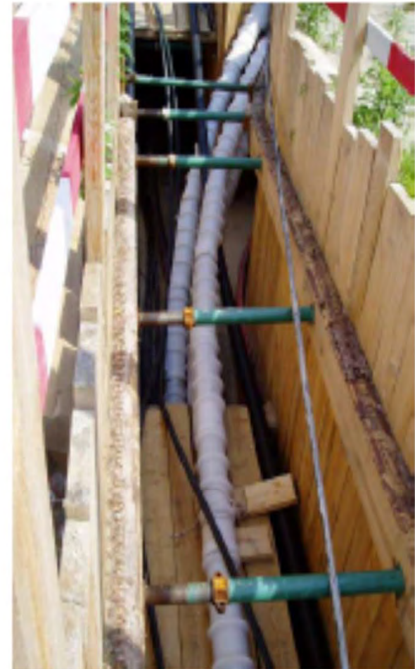
[Gepölzter Schacht 380kV Kabel]
