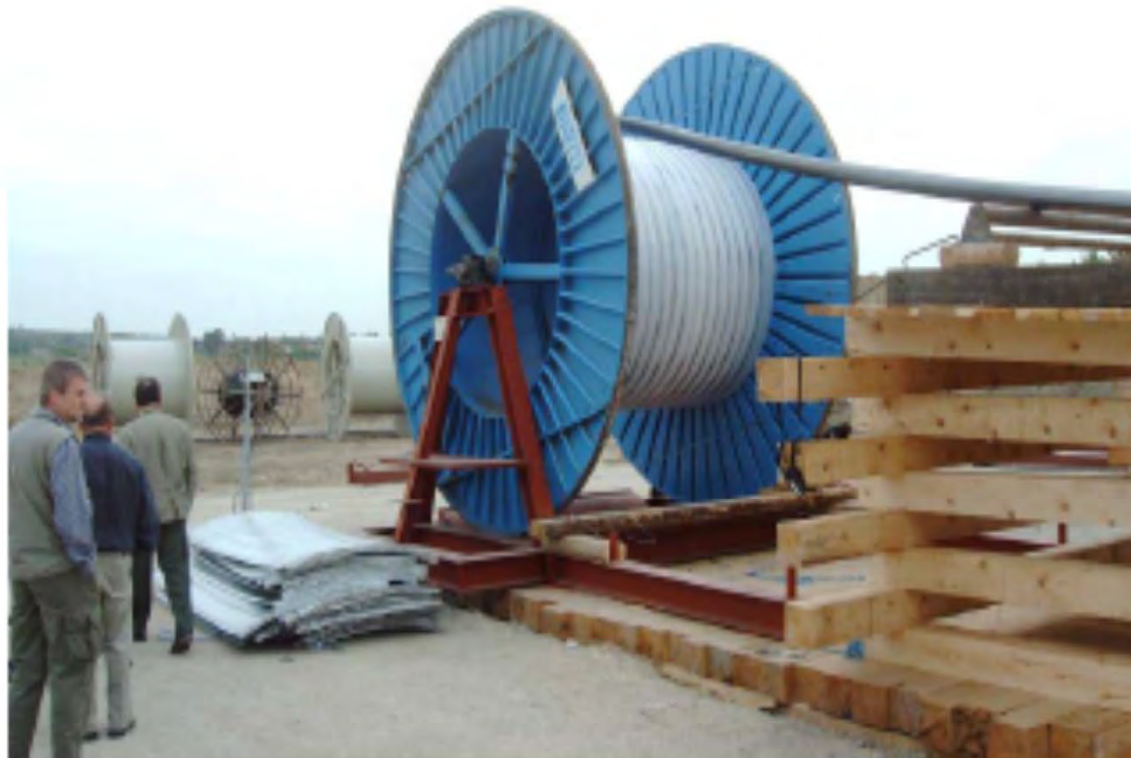
[Kabeltrommel 380kV Kabel bei der Verlegung 2004 in Wien]
